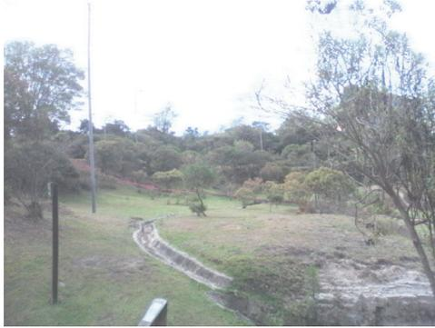
**Foto 3.** Canal rudimentario, forrado en plástico resistente, ideal para zonas con problemas de inundación.
